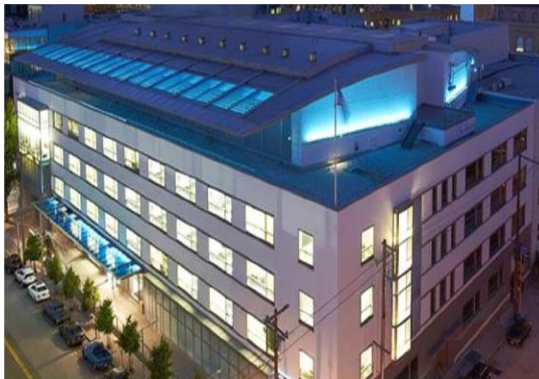
Data Center Farm, SFO, CA
